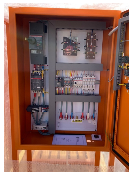
110kW Fan starter for De Beers
